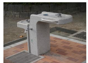
【新しく設置された流し】
